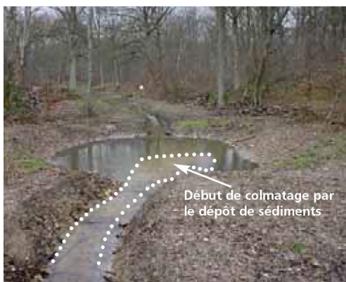
2003, 4 mois après le creusement du bassin.
